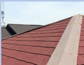
○ スレート拭き屋根 ○ 勾配あり
